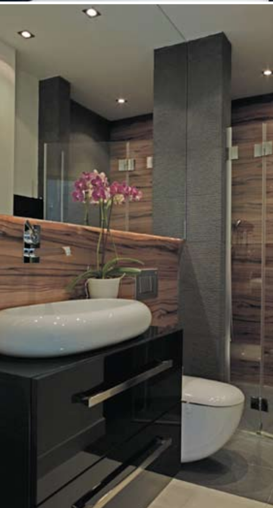
↑ W łazience na parterze zastosowano na ścianach płyty laminowane
